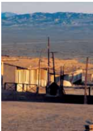
Calle del Campamento Obrero de Chacabuco.
