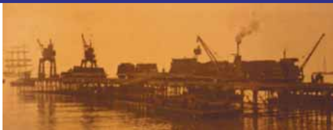
Muelle Salitrero del Puerto de Mejillones.
