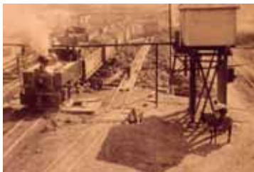
Descarga de caliche en el Buzón para su molienda.
